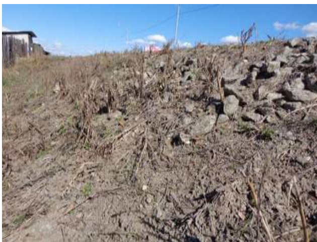
Рисунок 2.9 – Антропогенные грунты на откосах насыпи а/д
