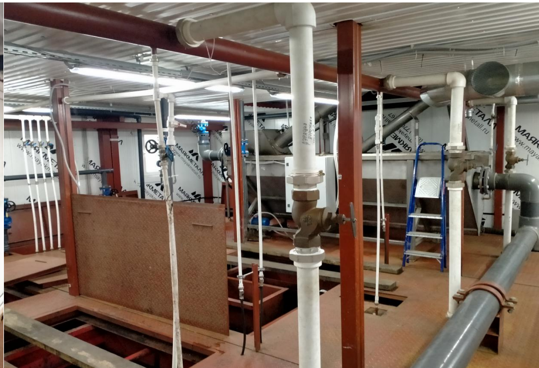
2 этаж Очистных сооружений с. Выдрино
